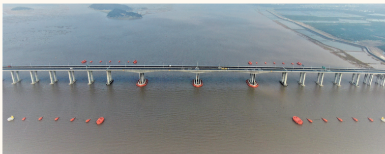
大型桥梁柔性防碰撞技术与装备已成功应用于湛江海湾大桥、象山港大桥、福建平潭海峡大桥等大型桥梁
